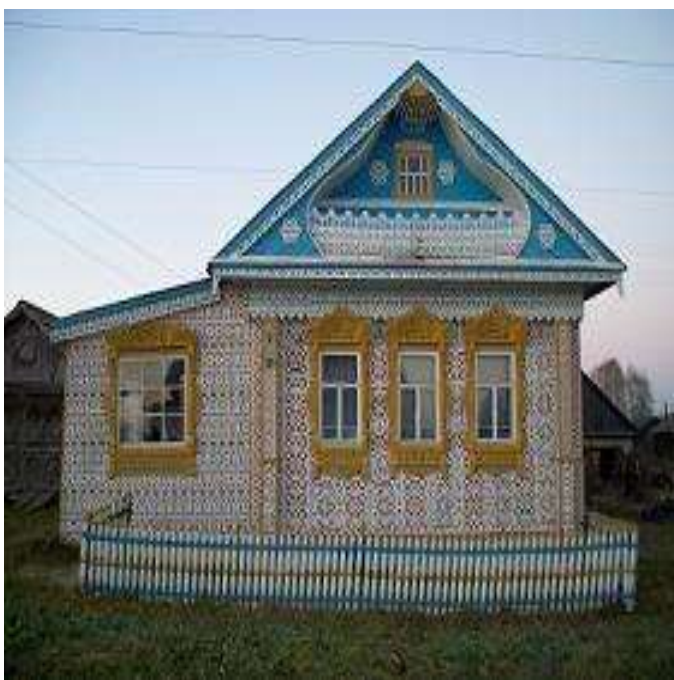
Рис.38. Дом, украшенный накладной резьбой
